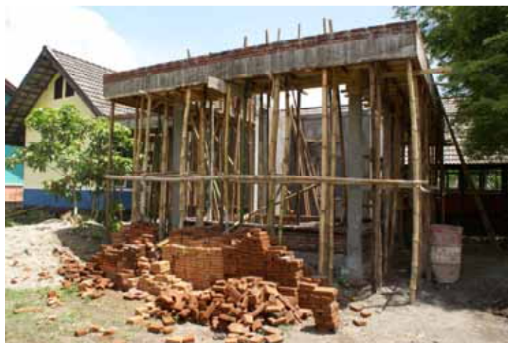
A nova biblioteca em construção
